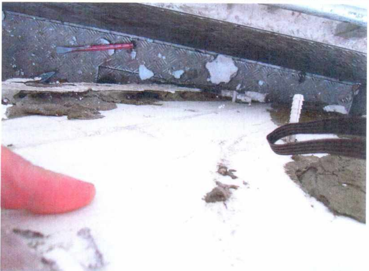
Фото 10: Фрагмент плиты утеплителя в зоне вскрытия
