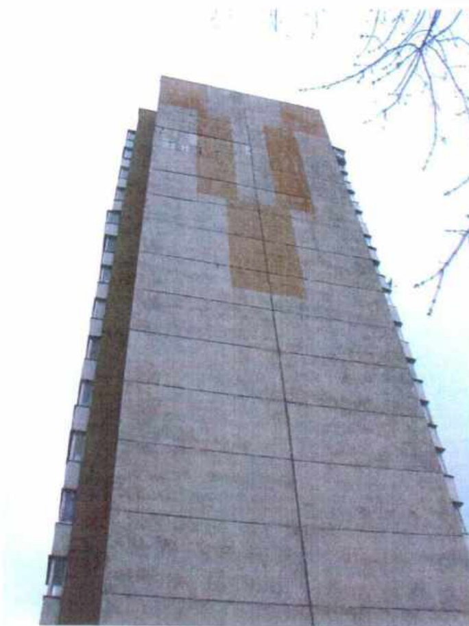
Фото 2: Фрагмент торцевого фасада по оси «2»
