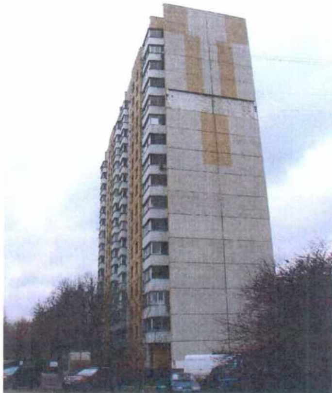
Фото 1: Торцевой фасад по оси «1»
