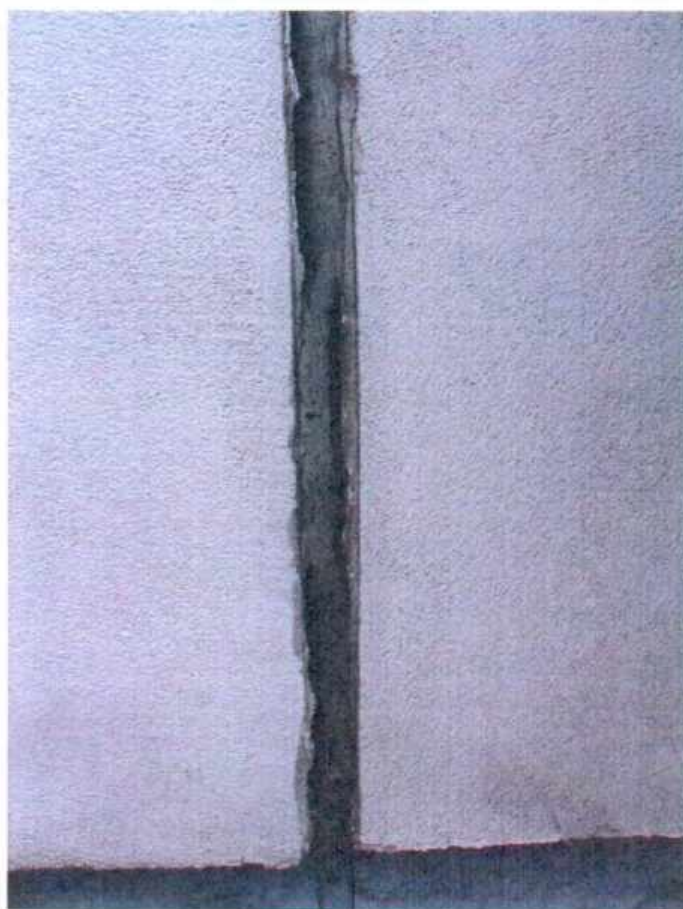
Фото 6: Фрагмент герметизации вертикального стыка плит утеплителя
