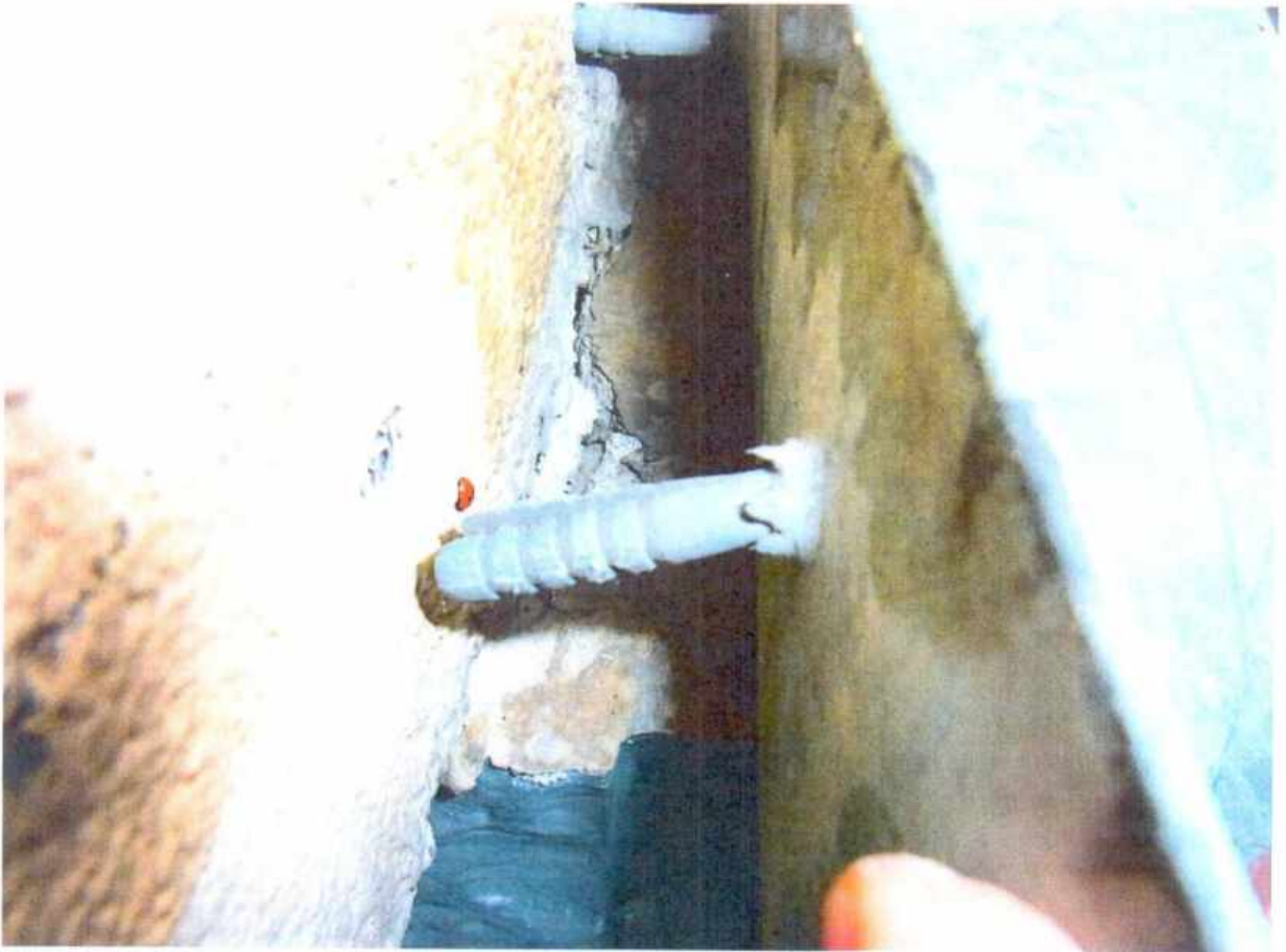
Фото 9: Фрагмент крепления отлива
