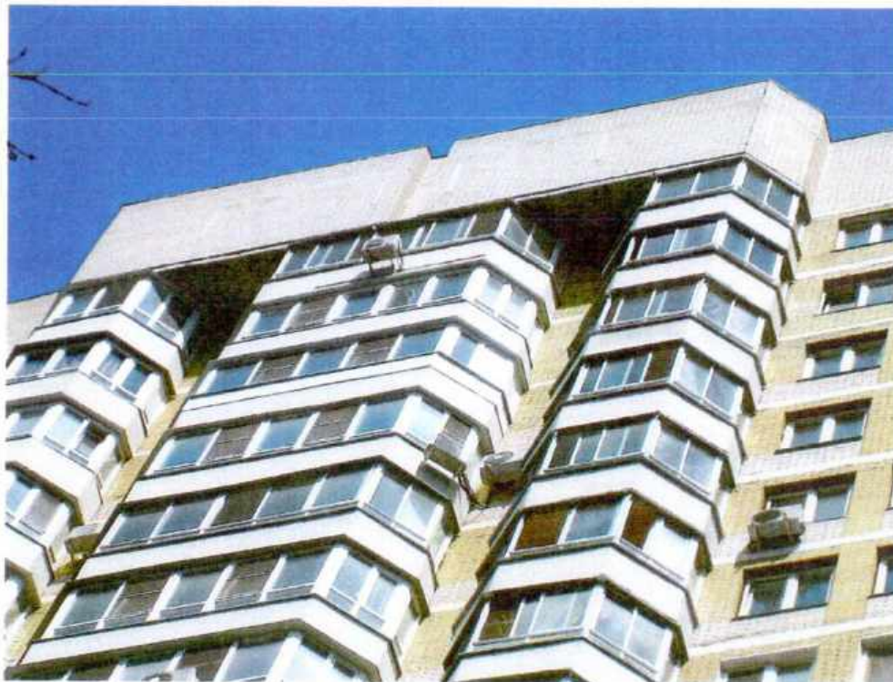
Фото2. Фасад здания в габаритах части помещений №№11,12,13,18 (смотри план БТИ) в уровне технического этажа и парапета крыши здания
