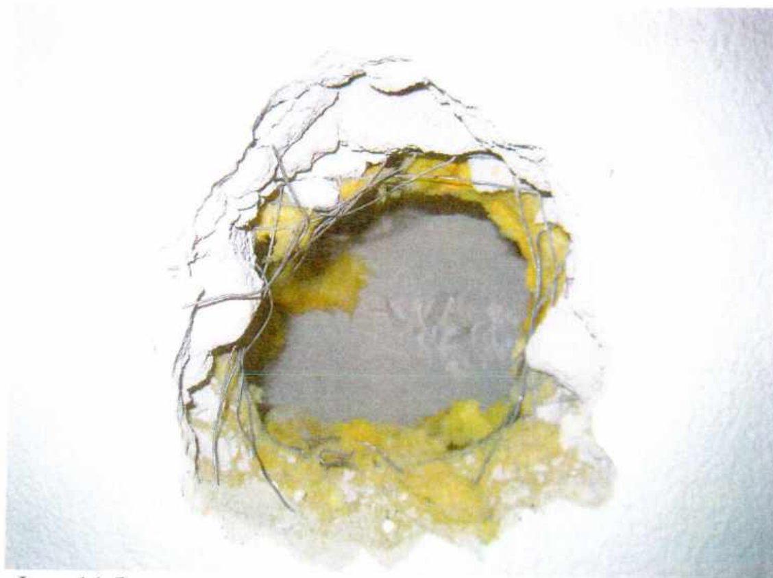
Фото 14. Зонд наружной стены здания со стороны помещений №№11,12,13,18 (смотри план БТИ) в уровне технического этажа
