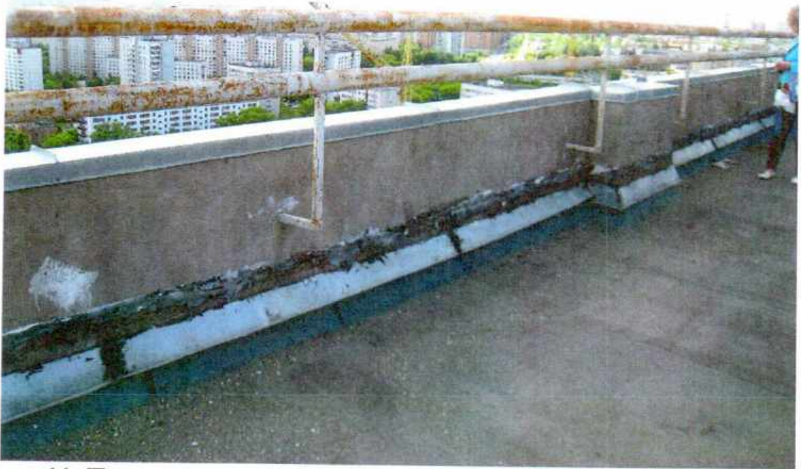
Фото 11. Парапет крыши над техническим этажом в габаритах части помещений №№11,12,13,18 (смотри план БТИ)
