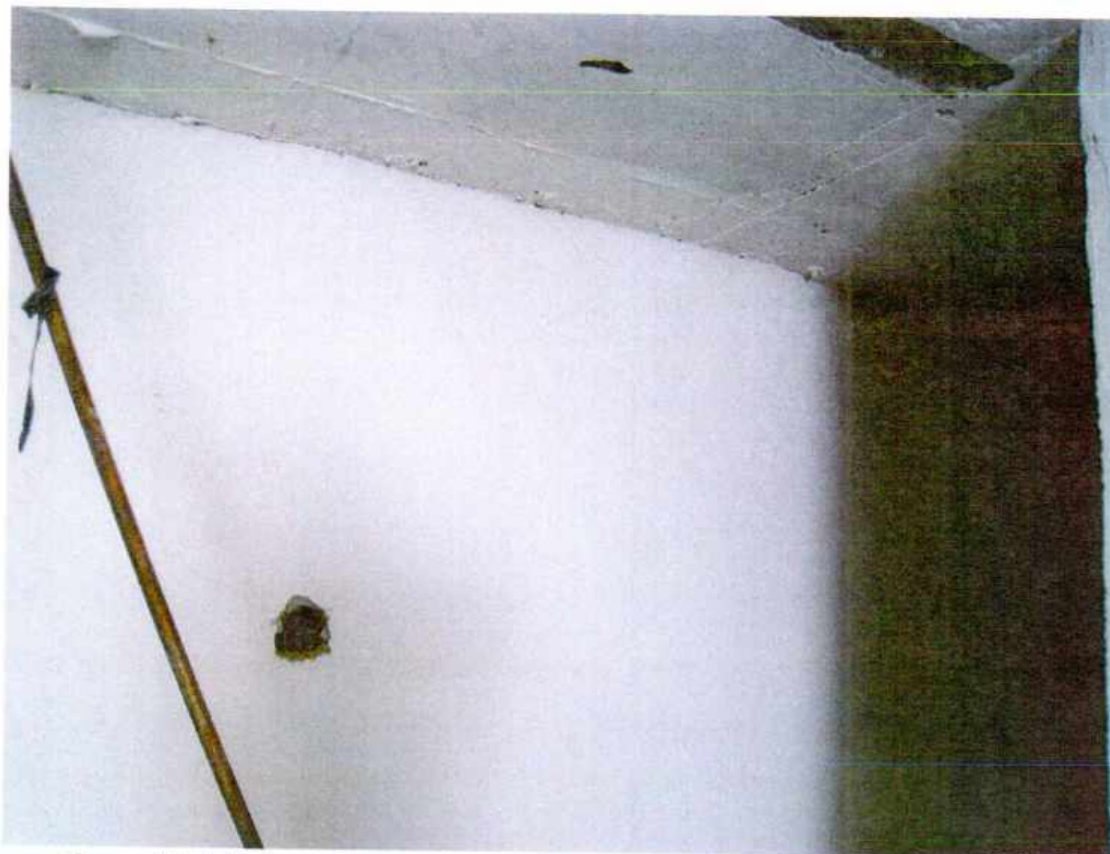
Фото 13. Наружная стена здания со стороны помещений №№11,12,13,18 (смотри план БТИ) в уровне технического этажа
